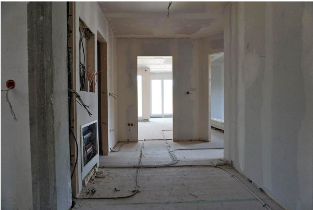
Flur mit Wohnungsverteilung
