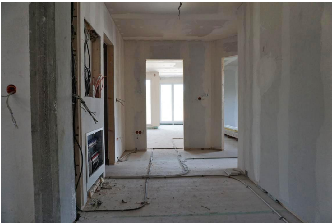
Flur mit Wohnungsverteilung
